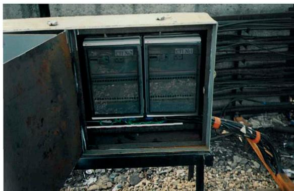
Рисунок 6. Общий вид шкафа управления электрообогревом стрелки (ШУЭС)
