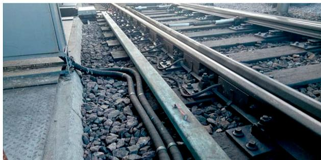
ется с помощью и посредством трубчатых электронагревателей (ТЭНов) разной мощности. Конструкция ТЭНов и схемы подключения к рельсам за время их эксплуатации претерпели большое количество доработок и модификаций. Доступность и мощность энергосетей, а также природные осо-
