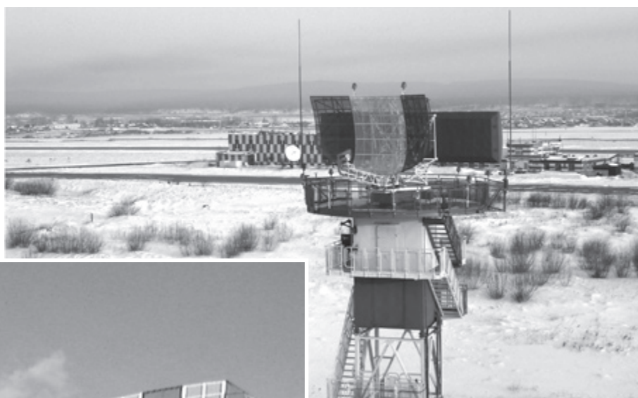
Рис. 1. Аэродромный радиолокационный комплекс с первичным и вторичным радиолокатором
